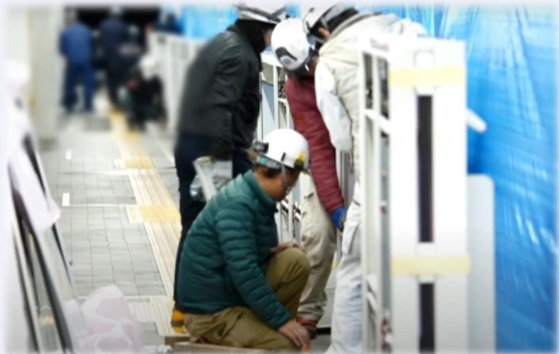
YouTube 大阪モノレールチャンネル【公式】より ～可動式ホーム柵設置風景～
