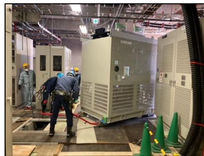
万博公園変電所更新工事
