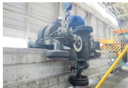
②台車吊り上げ
